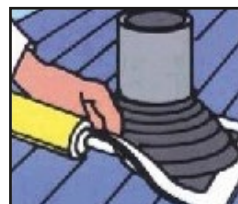
4. Dichtungsmasse auftragen
